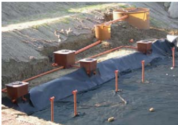
FASI DI REALIZZAZIONE DI UN IMPIANTO DI FITODEPURAZIONE CON DISTRIBUZIONE DEI LIQUAMI SU BACINO IN TERRA
